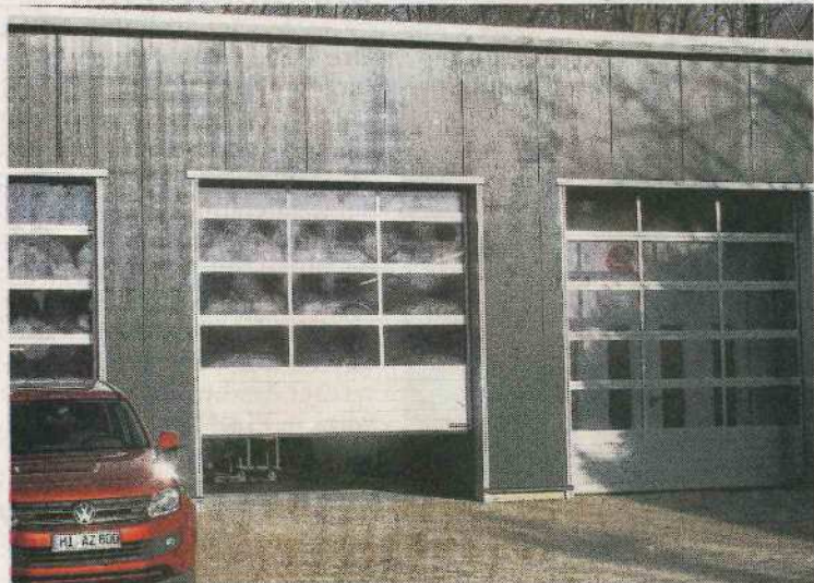
Die neue Halle steht auf dem hinteren Teil des Grundstücks. Hier ist die neue Lackiererei beheimatet.
